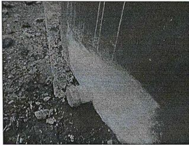
REHABILITACION Y ACONDICIONAMIENTO DE PILA DE ALMACENAMIENTO
