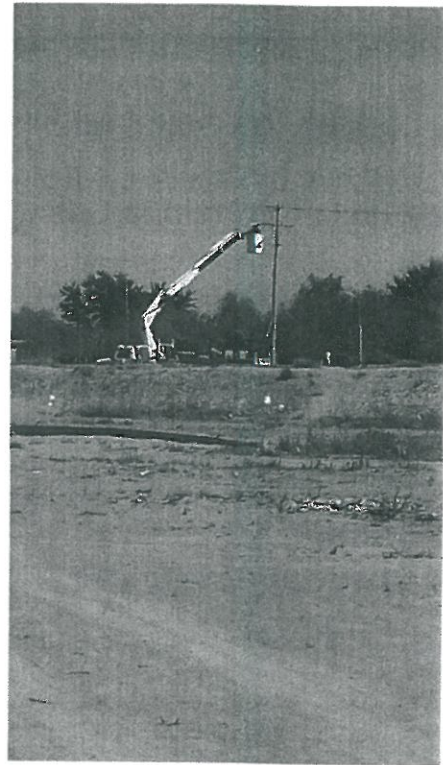
Tendido de líneas electricas para suministrar corriente a subestación.
