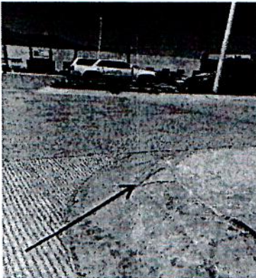
Hallazgo no. 7 Grietas en Guarnición en Área de Estacionamiento (Daño)
