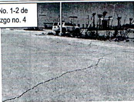
Hallazgo no. 4 Estacionamiento, en la Entrada al Acceso de Ambulancias Grieta que cubre 9 M2 de Superficie de Losa de Concreto.
