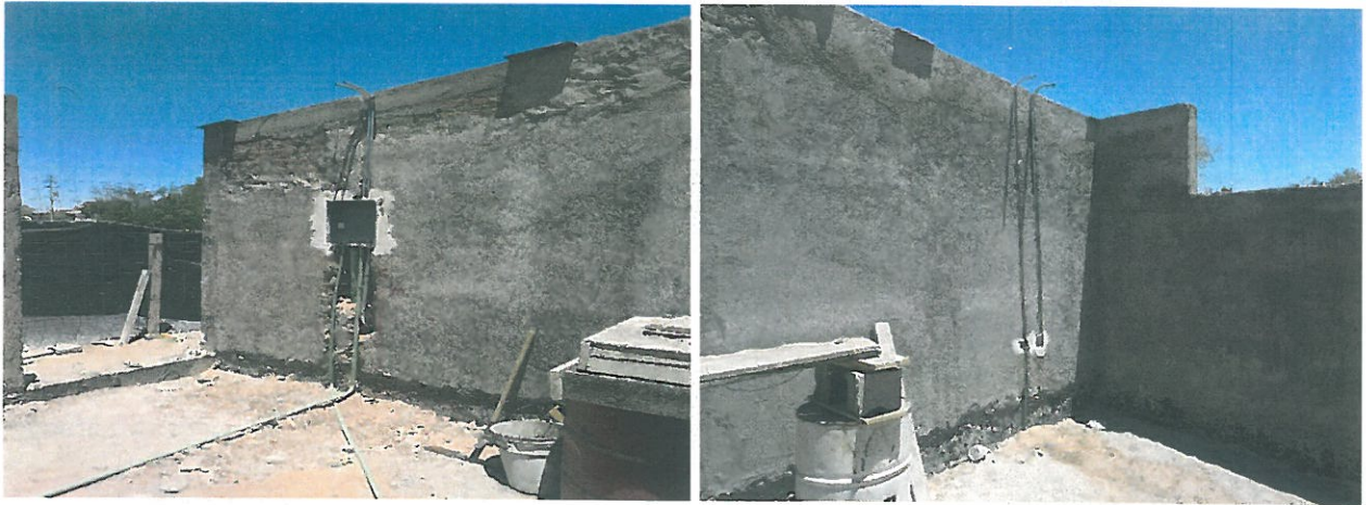
Como se muestra en ambas fotografías presenta trabajos de instalaciones eléctricas.
