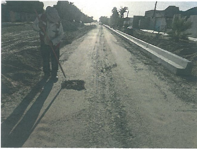
Muestreo de capa de sub-base para determinar su calidad y la realización de pruebas de compactación con el método de cono y arena.
