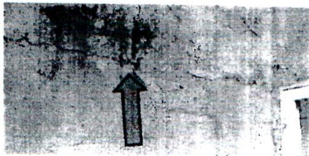
Situación que guarda baño y aplanado en muro agrietado.
