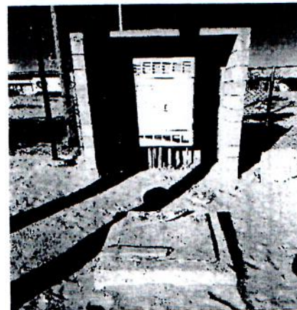
En estas fotografías se aprecia el tablero de alimentación principal a las aulas
