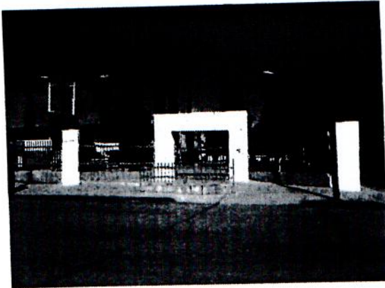
Vista de acceso Principal
