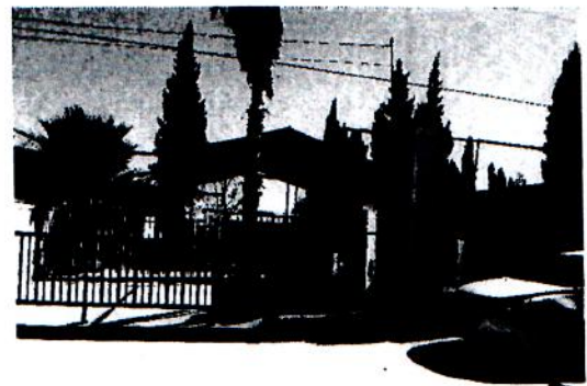
Vista Acceso a escuela
