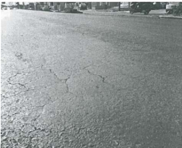
En estas fotografías se aprecia baches en Microcarpeta de 3.0 cm
