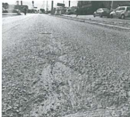
En estas fotografías se aprecia la mala calidad por demasiado desgaste en Microcarpeta de 3.0 cm de espesor.
