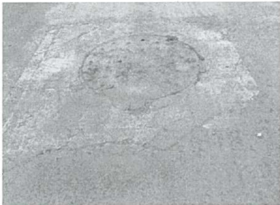
En estas fotografías se aprecia daño en Losa de Concreto de Resistencia F'c = 150 \text{ Kg/cm}^2 T.M.A 3/4"
