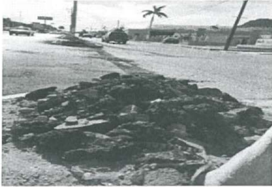
En estas fotografías se aprecia corte de Concreto Hidráulico, así mismo Falta Retiro de Material Producto de Corte en Pavimento.
