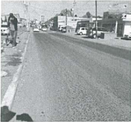
En estas fotografías se aprecia la mala calidad por demasiado desgaste en Microcarpeta de 3.0 cm de espesor.
