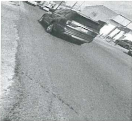
En esta fotografía se aprecia grietas en Micro carpeta de 3.0 cm de espesor elaborado en planta.
