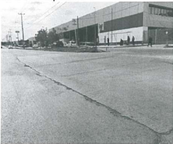
En estas fotografías se aprecia la mala calidad por demasiado desgaste en Microcarpeta de 3.0 cm de espesor.
