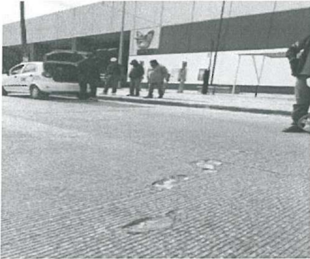
En estas fotografías se aprecia detalles de Huellas en Losa de pavimento de Concreto Hidráulico con resistencia F'c=250 \text{ kg/cm}^2 TMA 40 mm
