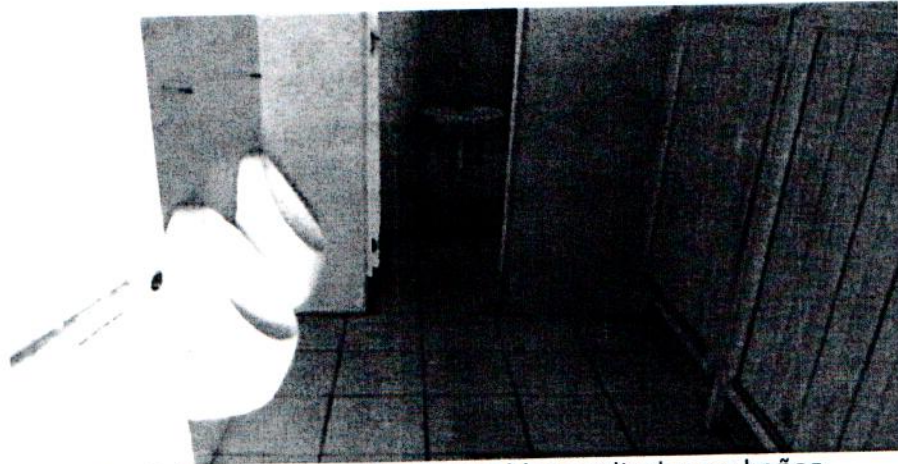
Suministro y colocación de muebles sanitarios en baños.
