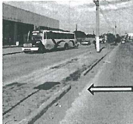
En estas fotografías se aprecia la Falta Retiro de Material Producto de Corte en Pavimento. (Ubicado enfrente de ISSSTESON)
