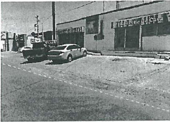
En esta fotografia se aprecia baches en Microcarpeta de 3.0 cm (Ubicado Enfrente del Negocio de Leche Yaqui)
