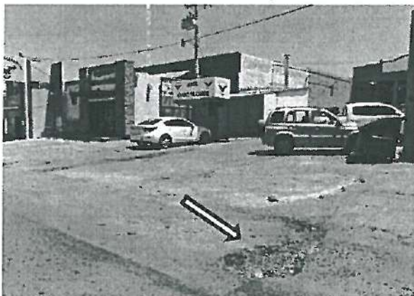
En esta fotografía se aprecia baches en Microcarpeta de 3.0 cm (Ubicado Enfrente Negocio de Leche Yaqui)
