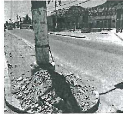
En estas fotografías se aprecia la Falta Retiro de Material Producto de Corte en Pavimento. (Ubicado enfrente de ISSSTESON)
