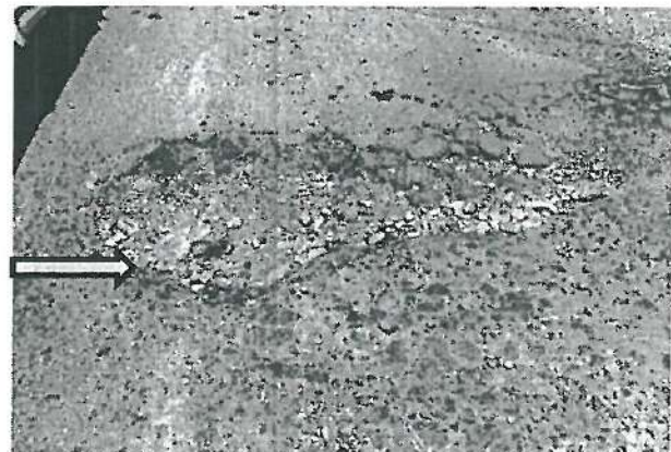
En esta fotografía se aprecia baches en Microcarpeta de 3.0 cm (Ubicado Enfrente Negocio de Leche Yaqui)
