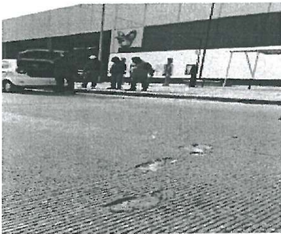
En estas fotografias se aprecia detalles de Huellas en Losa de pavimento de Concreto Hidráulico con resistencia F'c=250 \text{ kg/cm}^2 TMA 40 mm
