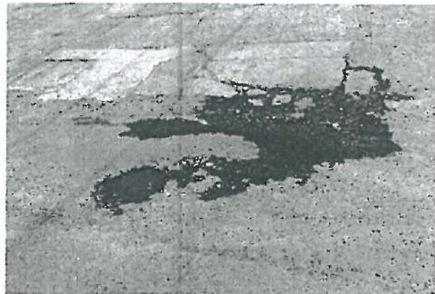
En esta fotografía se aprecia baches en Microcarpeta de 3.0 cm ( Ubicado Enfrente Negocio de Carnicería Villarreal)
