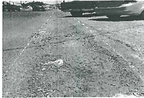
En esta fotografia se aprecia baches en Microcarpeta de 3.0 cm (Ubicado Enfrente del Negocio de Leche Yaqui)
