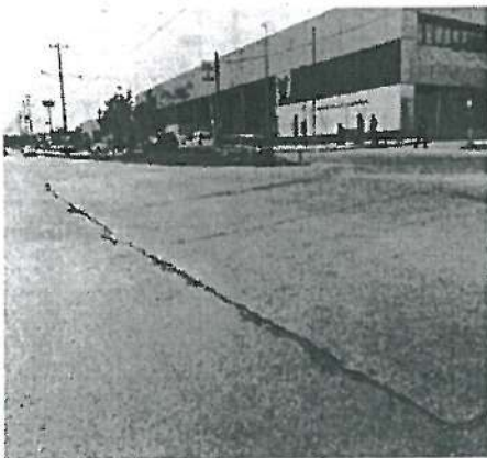
En estas fotografias se aprecia detalles de Huellas en Losa de pavimento de Concreto Hidráulico con resistencia F'c=250 \text{ kg/cm}^2 TMA 40 mm
