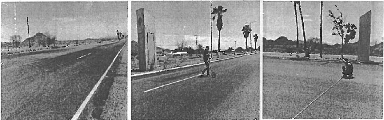
En estas fotografías se presentan los trabajos
