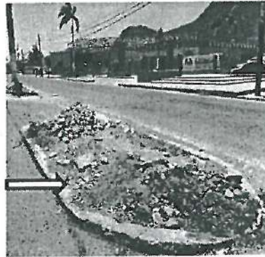
En estas fotografías se aprecia la Falta Retiro de Material Producto de Corte en Pavimento. (Ubicado enfrente de ISSSTESON)
