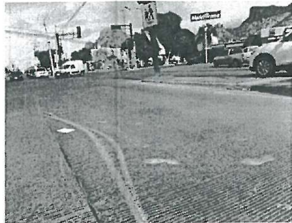
En estas fotografias se aprecia detalles de Huellas en Losa de pavimento de Concreto Hidráulico con resistencia F'c=250 \text{ kg/cm}^2 TMA 40 mm
