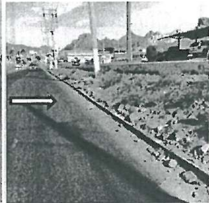
En estas fotografías se aprecia la Falta Retiro de Material Producto de Corte en Pavimento. (Ubicado enfrente de ISSSTESON)
