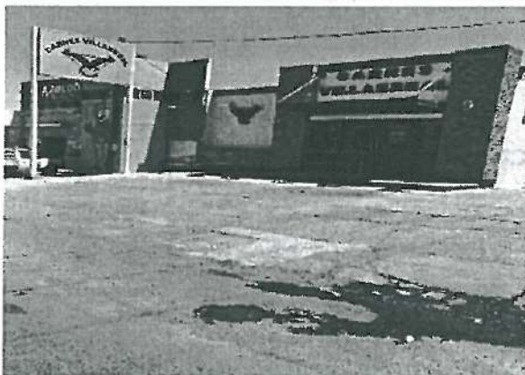
En esta fotografía se aprecia baches en Microcarpeta de 3.0 cm ( Ubicado Enfrente Negocio de Carnicería Villarreal)
