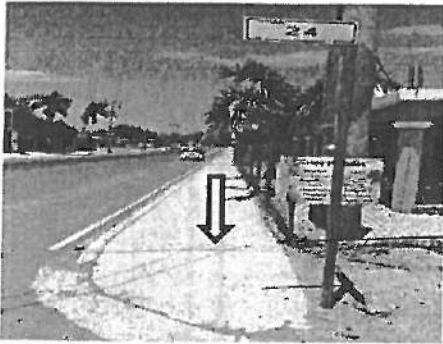
En estas fotografías se aprecia Grietas en Banqueta de Concreto Hidráulico con resistencia F'c=200
