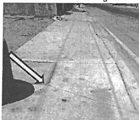
En estas fotografías se aprecia detalles de Huellas en Banqueta de Concreto Hidráulico con resistencia F'c=200 kg/cm 2
