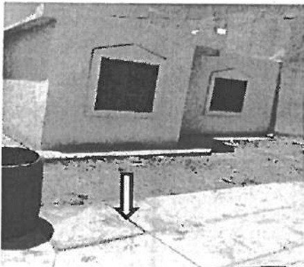
En estas fotografías se aprecia detalles de Huellas en Banqueta de Concreto Hidráulico con resistencia F'c=200 kg/cm 2
