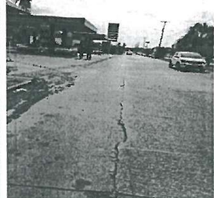
En estas fotografias se aprecia detalles de Huellas en Losa de pavimento de Concreto Hidráulico con resistencia F'c=250 \text{ kg/cm}^2 TMA 40 mm
