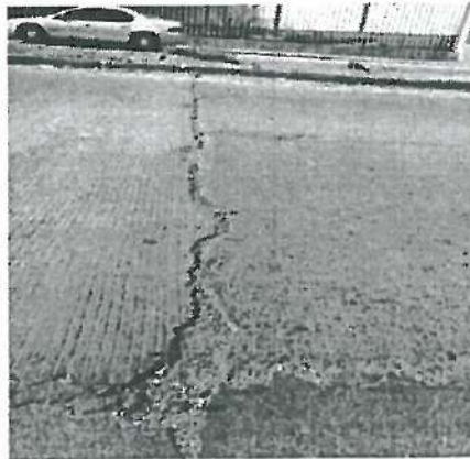
En estas fotografias se aprecia detalles de Huellas en Losa de pavimento de Concreto Hidráulico con resistencia F'c=250 \text{ kg/cm}^2 TMA 40 mm
