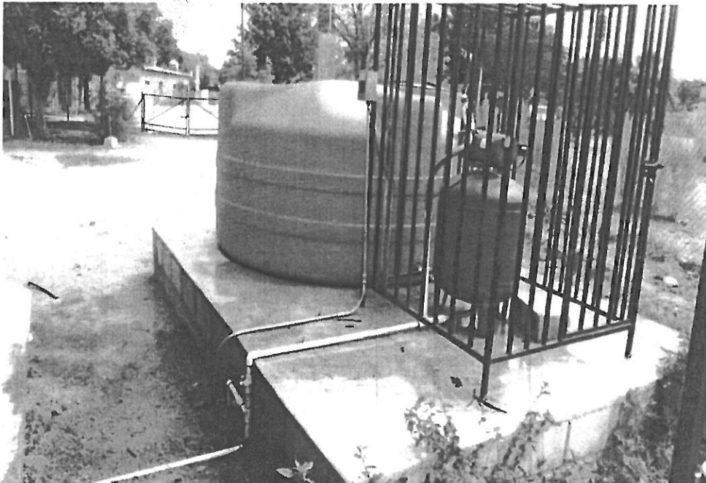
Suministro y colocación de cisterna e hidroneumatico.
