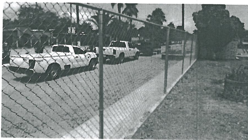
Cerco perimetral y rodapié.
