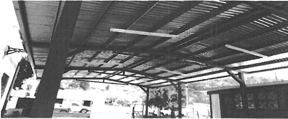
Suministro y colocación de lamparas 2x74 W Slim-Line en tejabán.
