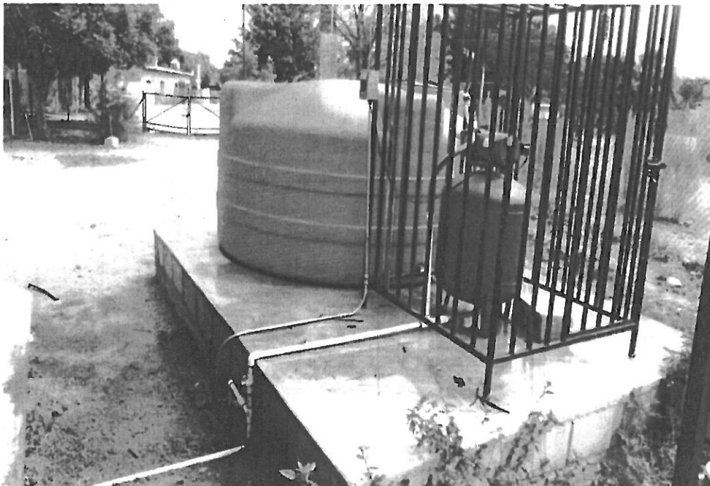
Suministro y colocación de cisterna e hidroneumatico.
