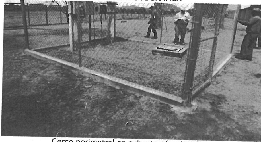
Cerco perimetral en subestación eléctrica.
