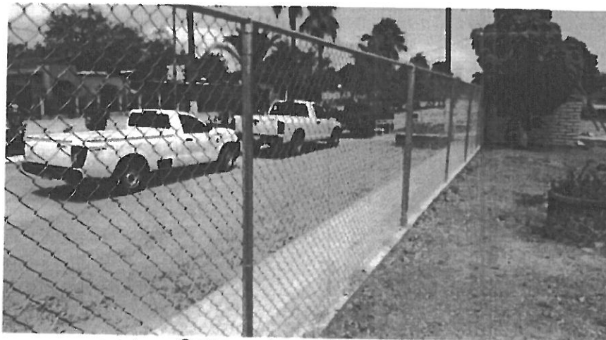
Cerco perimetral y rodapié.
