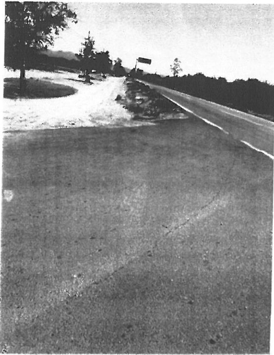
PAVIMENTO EN LA BAJADA
