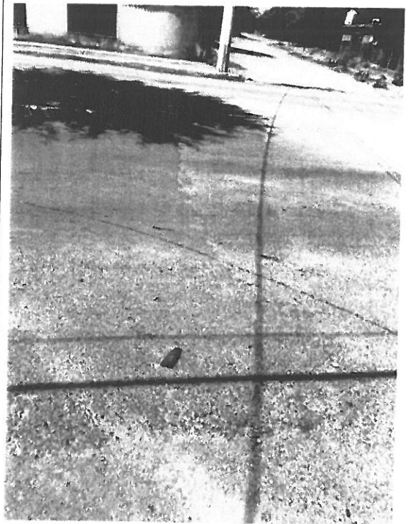
FIN DEL TRAMO KM 2+000
