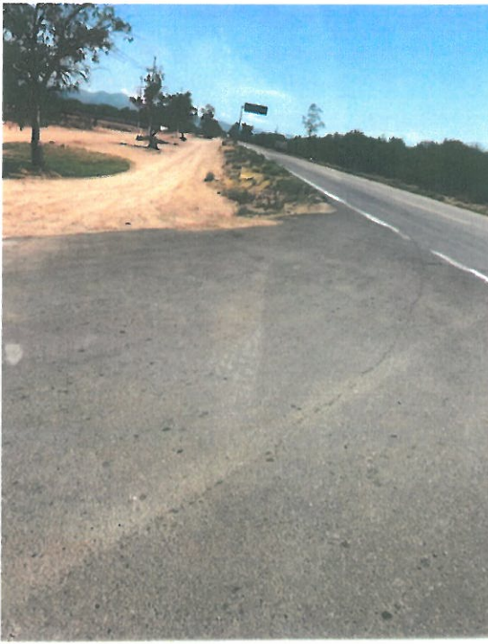
PAVIMENTO EN LA BAJADA
