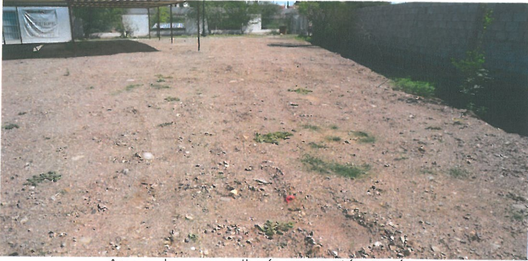
Area en la que se rellenó y compactó socavón.
