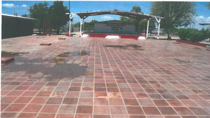
Area en la que estaba situado el tejaban que se demolió.
