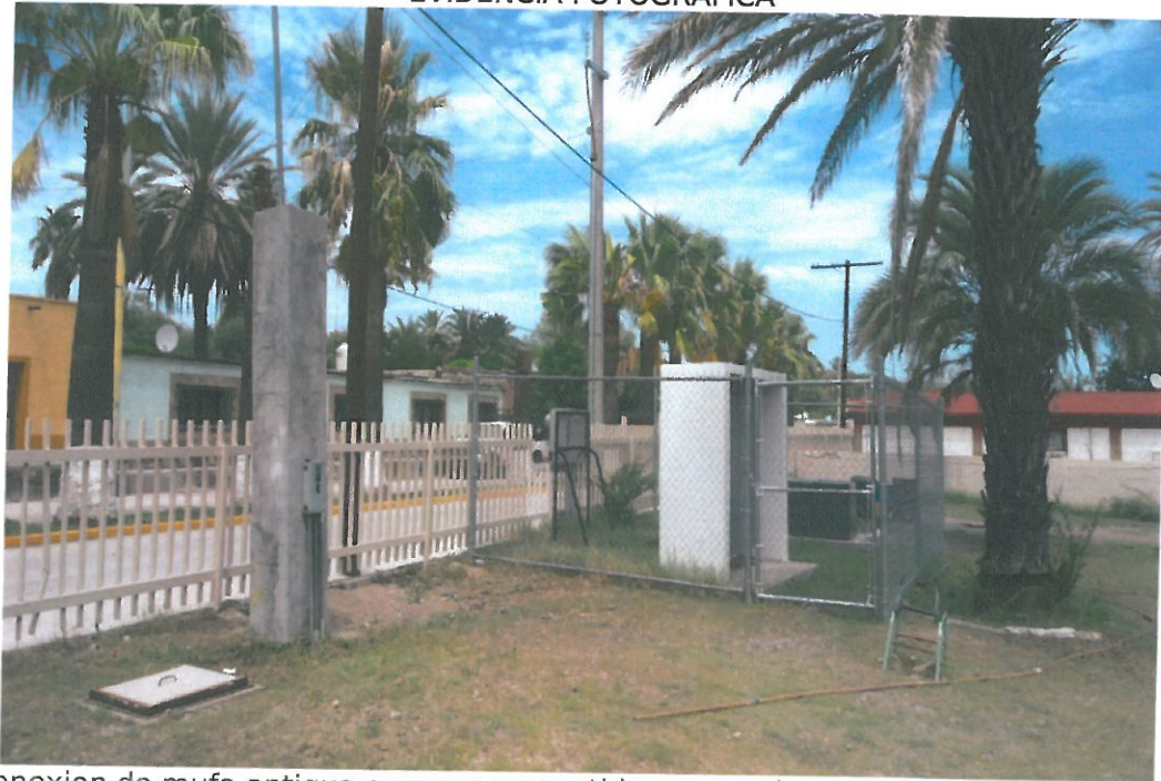
Interconexion de mufa antigua a nueva acometida, centro de medición y subestación de 75 KVA.
