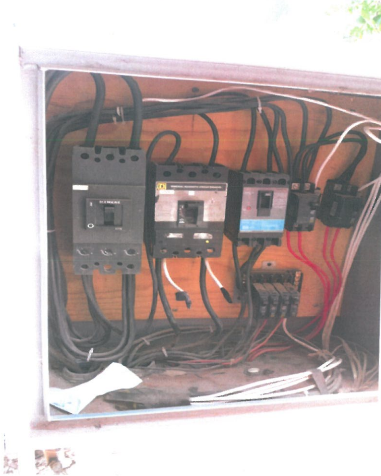
Rehabilitación de tablero principal
