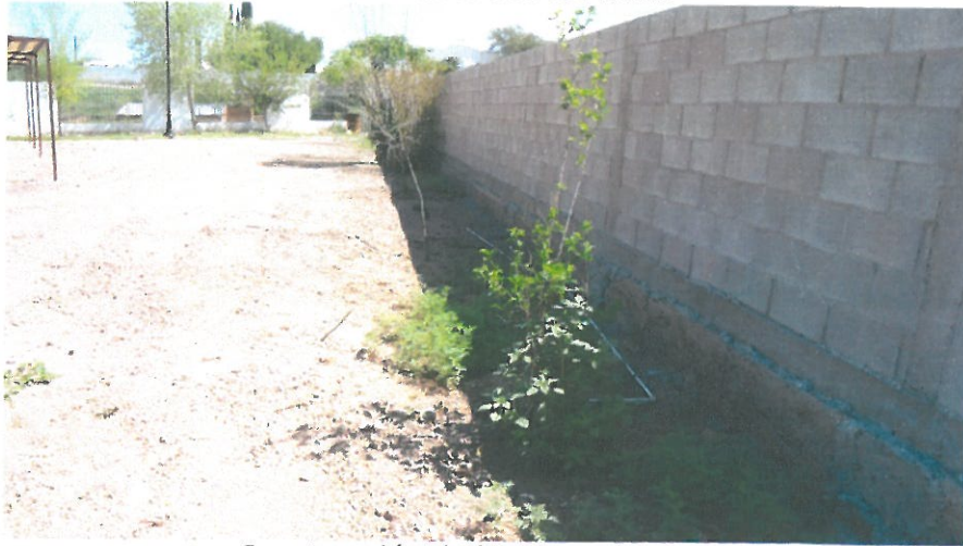
Construcción de barda perimetral.
