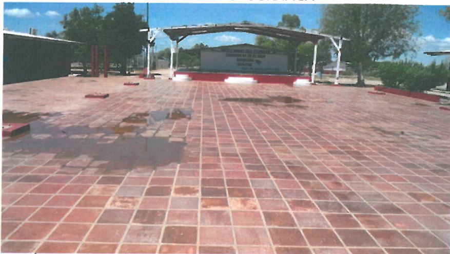
Área en la que estaba situado el tejaban que se demolió.
