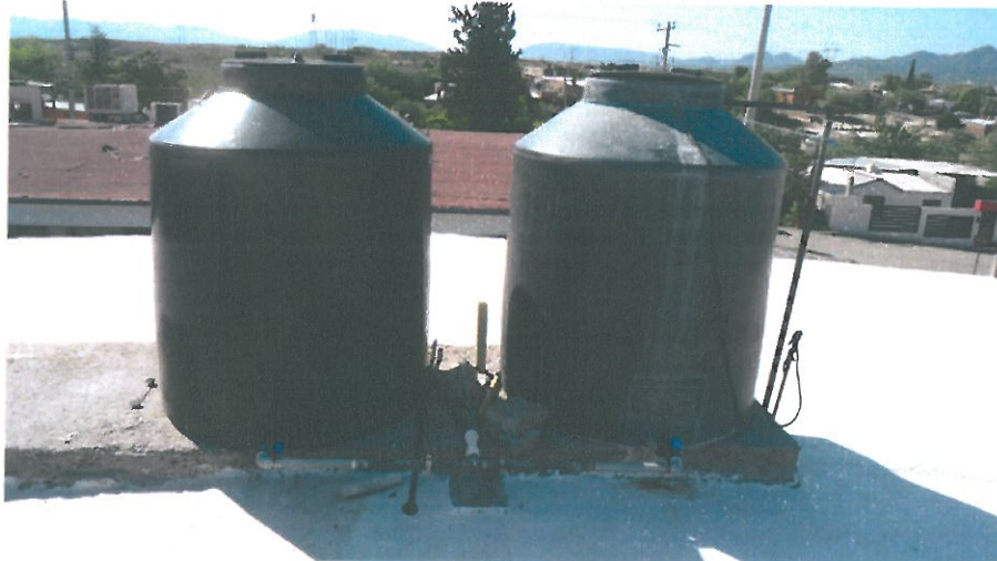
Impermeabilización de azotea y rehabilitación de 2 tinacos.
