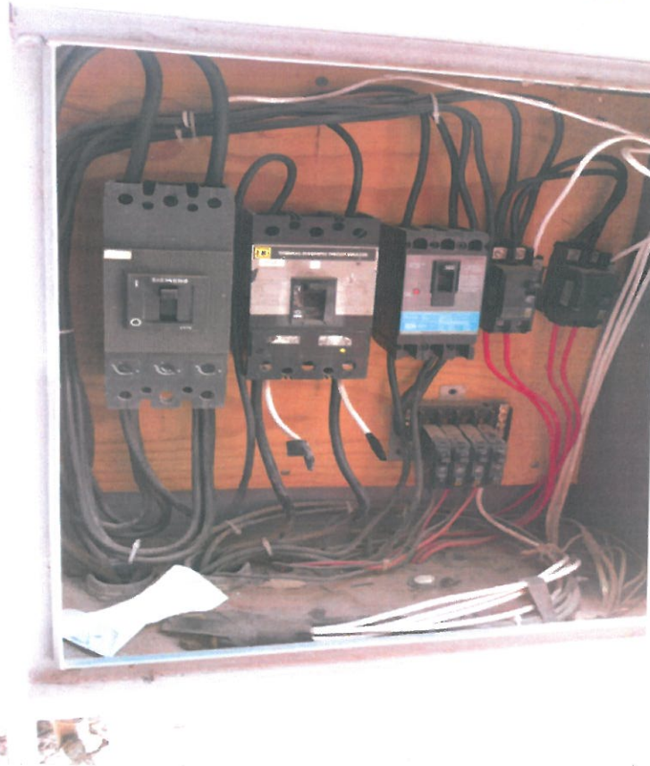
Rehabilitación de tablero principal
