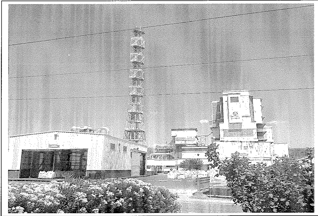
Instalaciones de la planta de MOLYMEX en Cumpas, Sonora.
