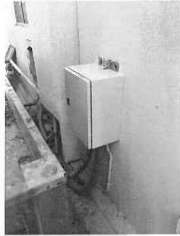
Fotografías que muestran el interruptor y el gabinete nema 3R, falla eliminada.
