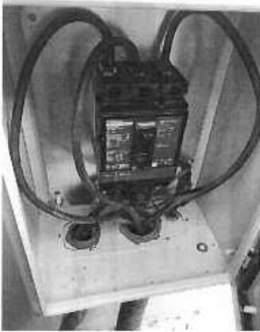
Fotografías que muestran el interruptor y el gabinete nema 3R, falla eliminada.
