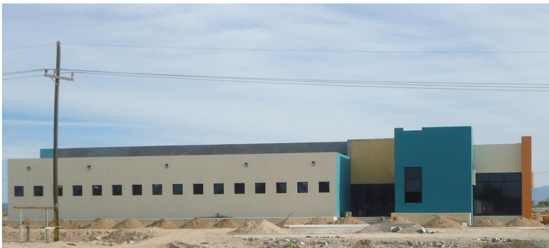
Puerto Libertad: Módulo integral de: 6 aulas, laboratorio polifuncional, oficinas administrativas, bebederos y servicios sanitarios. Aplicación de dos inversiones, una de $4,615,000.00 y otra de $ 4,385,000.00. Terminado
