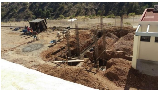
Avance de un aula en plantel Nogales II
