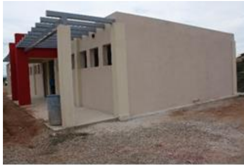
Dos aulas en plantel Nogales II
