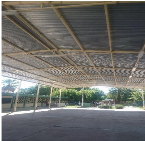
Rehabilitación eléctrica de tejaban de explanada cívica
