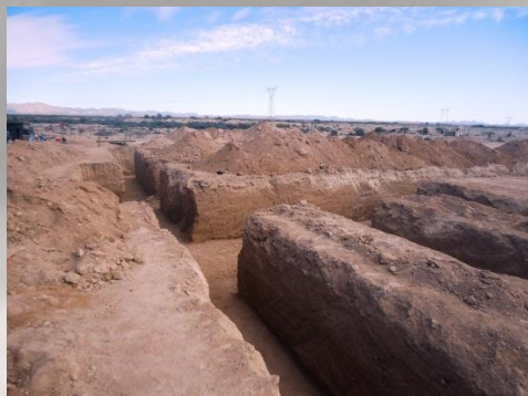
Inicia la construcción del módulo integral del plantel EMSaD de Puerto Libertad.
