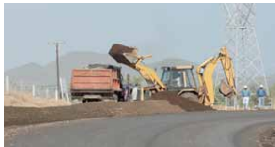
PAVIMENTACIÓN DE LA CALLE 200 EN EL MUNICIPIO DE CAJEME.
