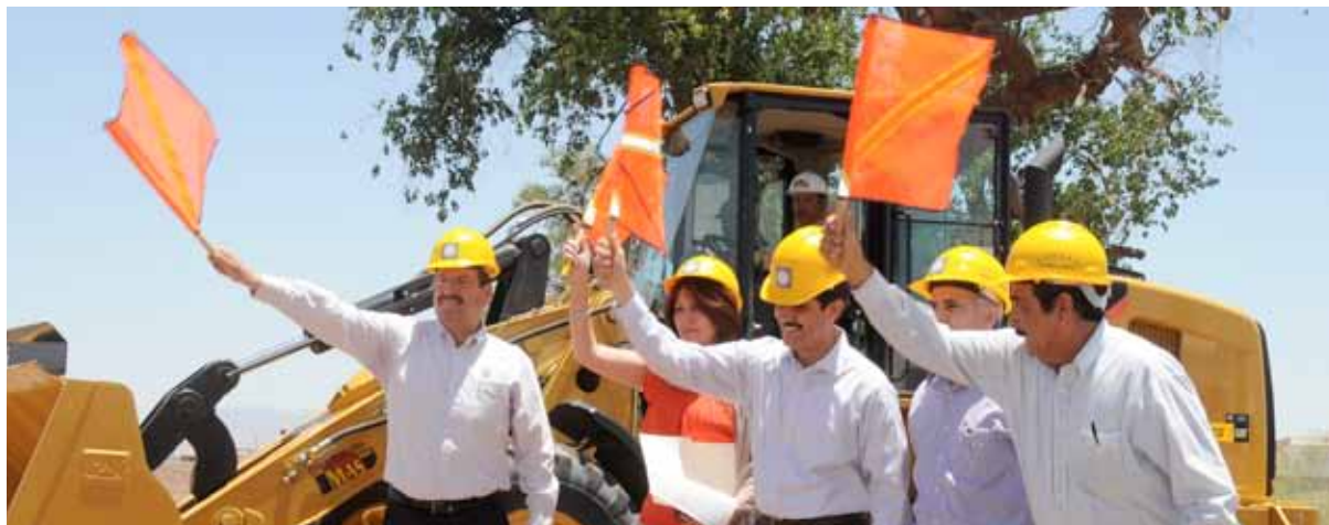
BANDERAZO A LOS INICIOS DE LA OBRA DE LA CALLE 200.
